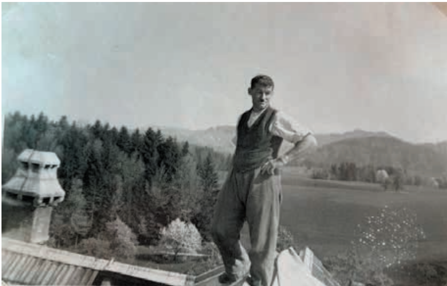
Verwalter Brändli auf dem Dach des Altbaus
