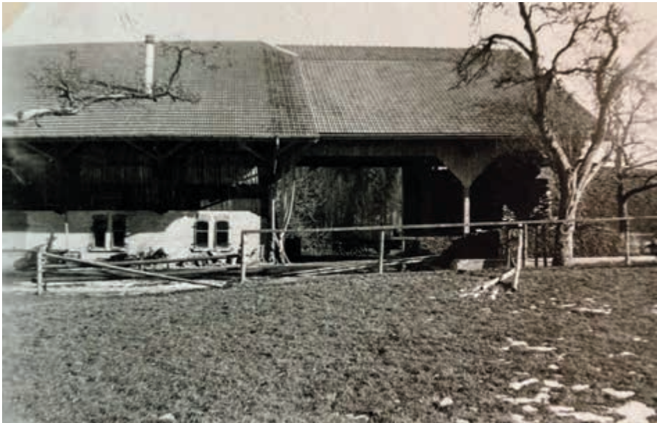
Der zusätzliche Scheunenanbau nach Süden mit der neuen Hocheinfahrt von 1929, mit einem aufgeschütteten Erdwall (von rechts her auf dem Bild)
