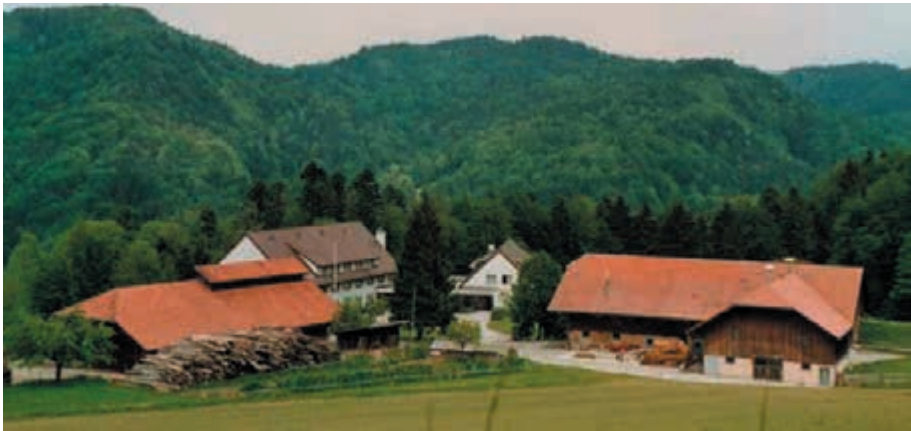
Der Stallanbau von 1975 ganz rechts an der Bliggenswilerstrasse
