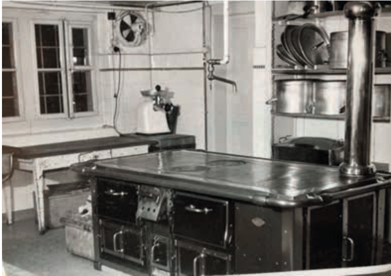
Der mit Holz beheizte Kochherd in der neuen Küche
